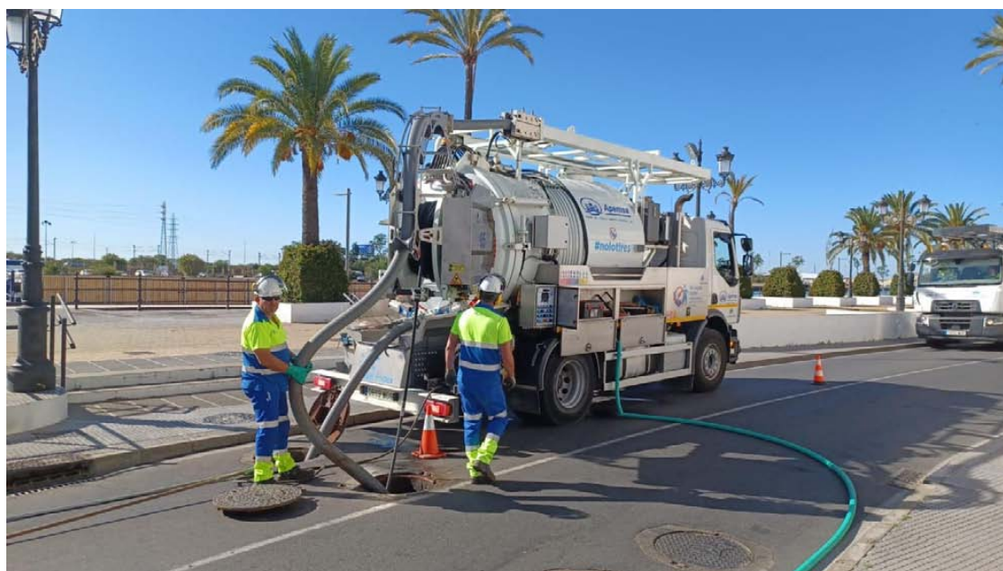
LIMPIEZA RED DE SANEAMIENTOS POR PARTE DE APEMSA. - VIVA
